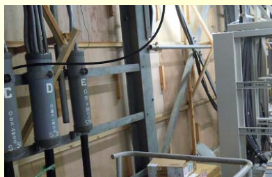
＜空調設備を新設するとともに ベニヤから本格壁に取替え空調効果を確保＞
