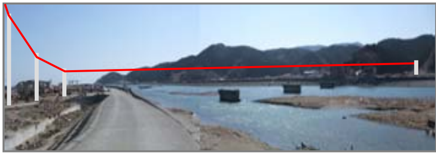
応急復旧 (河川上越しにケーブルを長スパン敷設)
